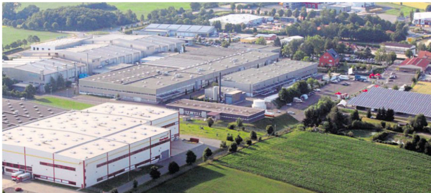
Siemens Healthineers (hinten) bildet nicht nur das Herz im Kemnather Gewerbegebiet: Die neuen steuerpotenten Unternehmen, die sich in Kemnath angesiedelt haben, stammen ebenfalls aus dem Umfeld der Firma, wie aus verschiedenen Wortbeiträgen im Kemnather Stadtrat zu erfahren ist. Bild: stg
